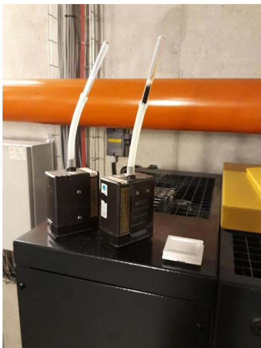
Bild 2 Stationär mätning vid rökgasrening
