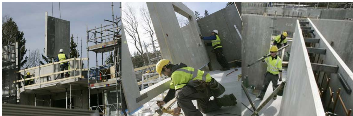
Figur 7: VST-systemet med skalformar som fylls med betong (Skanska, u.d.).
