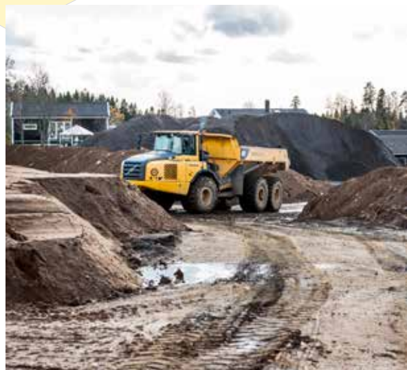
Under byggtiden är det inte mycket som skvallrar om att det är en ny kyrkogård som växer fram.
