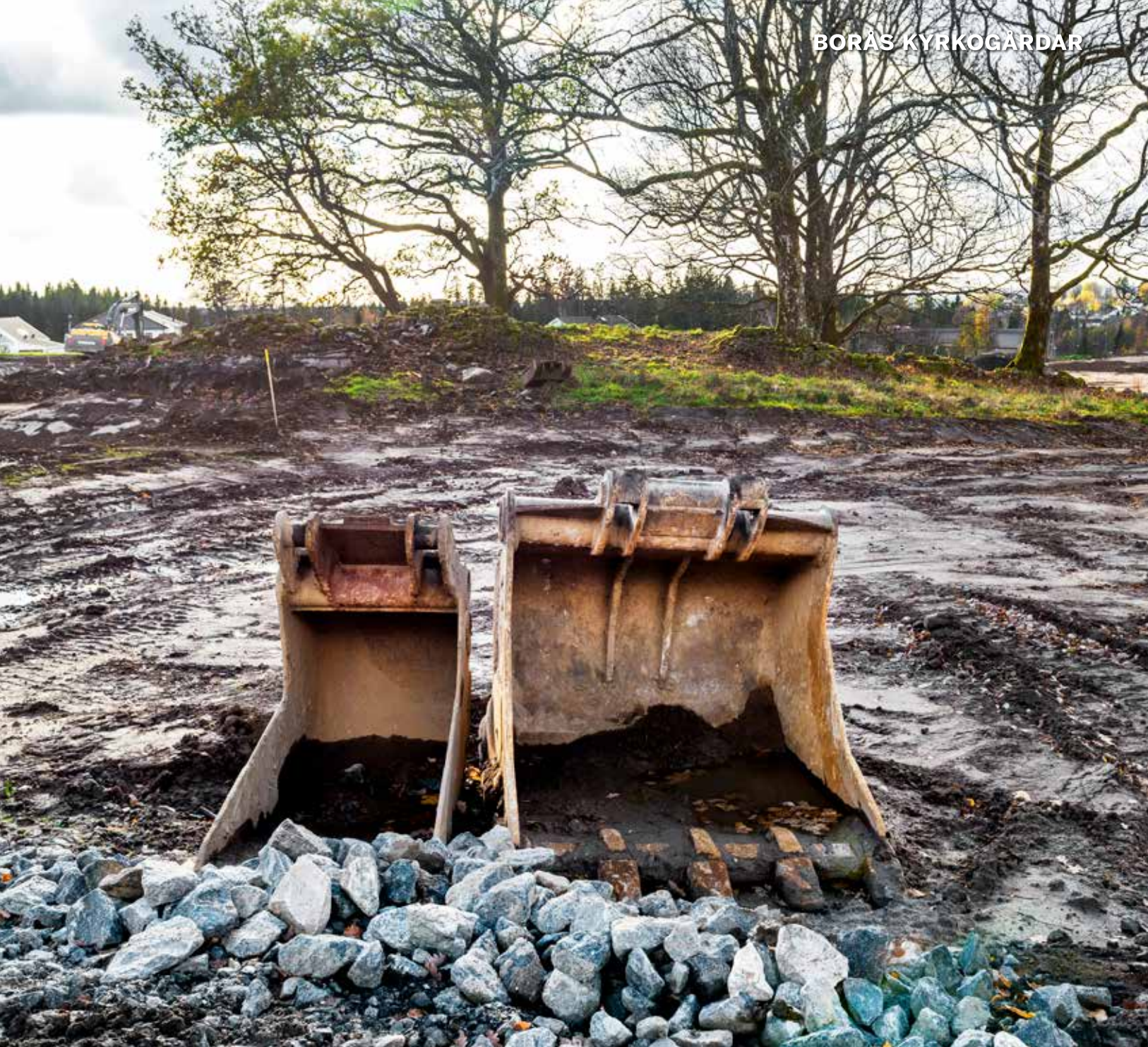
Här, där skoporna står, ska det omdiskuterade utomhusgymmet byggas. I dungen i bakgrunden finns den gamla järnframställningsplatsen där besökarna exempelvis ska kunna sitta med medhavd fikakorg.
